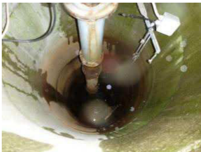
Figur 1.15: Brønd 5 ved pumpegraven
