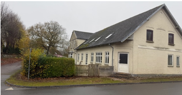
Fra ansøgningen: Eksisterende bygning (facade mod syd og øst) – set fra sydøst
