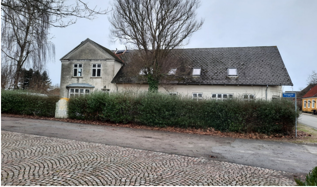
Fra ansøgningen: Eksisterende bygning (facade mod syd) – set fra syd
