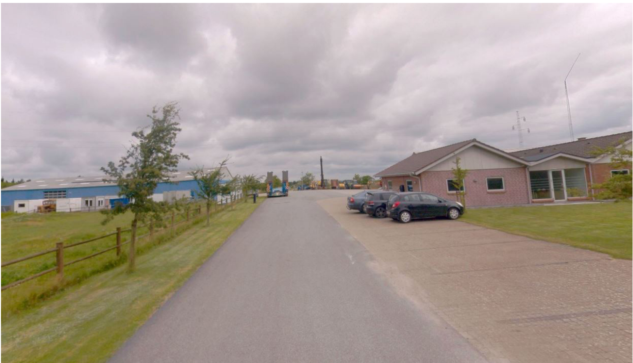
Billede 2. Billede set fra den gennemgående vej mellem Stensbækvej og Nordvangsvej. Her ses ankomstområdet med administrationsbygninger og parkeringsområder til højre i billedet, og maskinhal til venstre i billedet.
