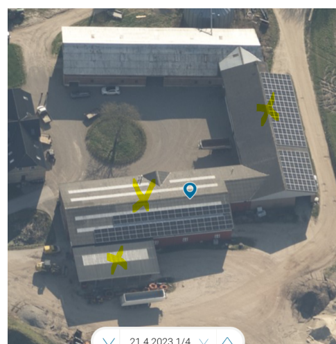
Skråview fra 2023 – Copyright Klimadatastyrelsen Tre bygningerne med gult kryds ændrer anvendelse til entreprenørvirksomheden
