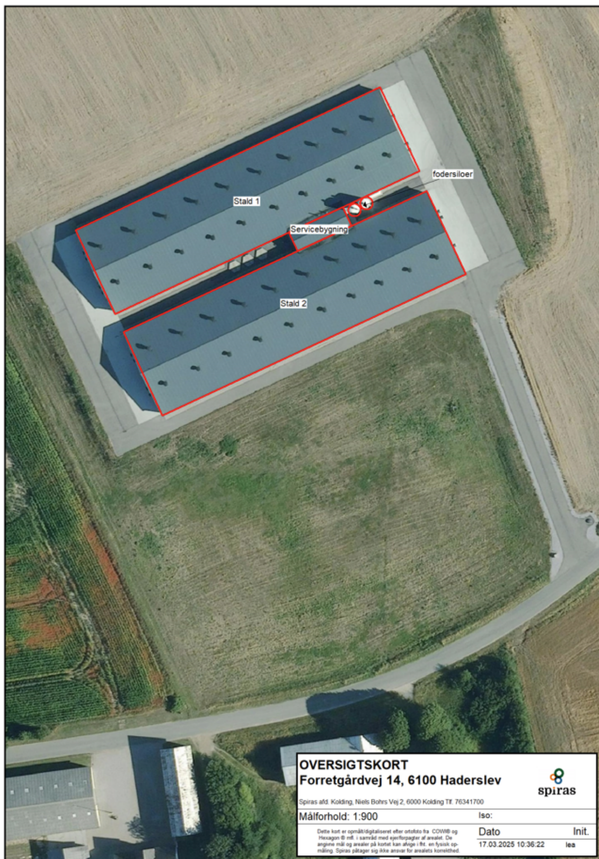
Figur 1 Stalde på Forretgårdvej 14
