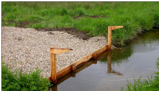
Parallelt med vandløbet kan der nedgraves kraftige, tætsluttende træplanker, som forhindrer nedtrædning af brinken. Ind mod marken stabiliseres med grus. Der hegnes som vist på billedet for at hindre dyrene i at træde ud i vandløbet.
