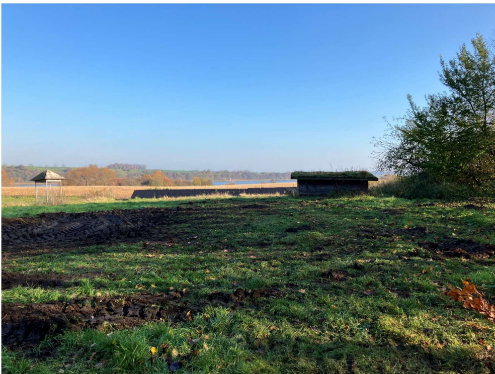
Foto 2. Fotoet viser solcellernes placering i lavningen (hvor den gule pil peger) set fra den oprindeligt tilladte placering, som ligger højere i terrænet. Det ses, at solcellerne ligger så lavt, at de ikke tager udsynet til selve søen. Det ses også, at der er skygge på den oprindeligt tilladte placering for solcelleanlægget.
