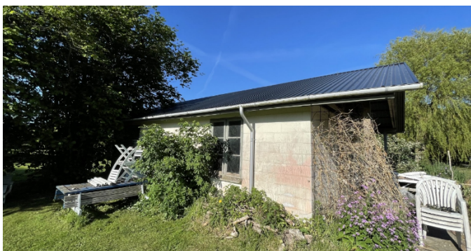
Fra ansøgningen: Billede af udhus (bygning 2) fra vest
