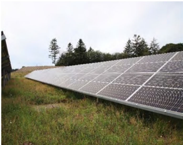
Billede 2-2 Eksempel på solcellepaneler monteret på faste stativer (til venstre) og monteret på stativer med trackersystem (til højre)
