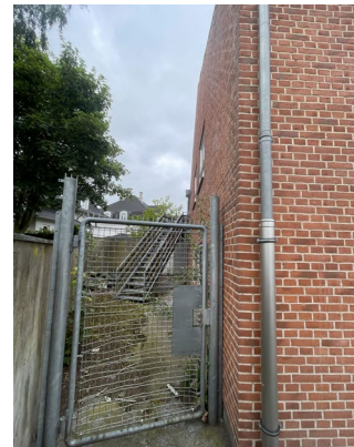
Bilag 5.31. – Facade mod syd trappe ned til baggård
