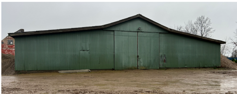
Fra ansøgningen - Eksisterende hal, som ønskes benyttet til parkering af lastbiler
