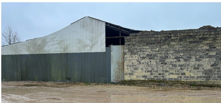
Fra ansøgningen - Eksisterende hal, som ønskes benyttet til parkering af lastbiler
