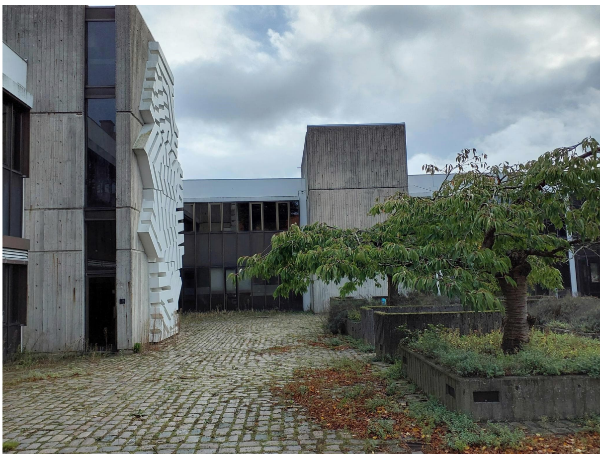
Figur 3 Foto af midten af den undersøgte bygning, taget fra vest mod øst, ind i et indhak med gårdmiljø og små træer.
