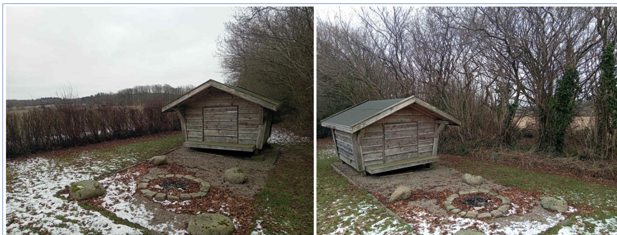
Figur 4 Fotos fra ansøgningen af shelteret.
