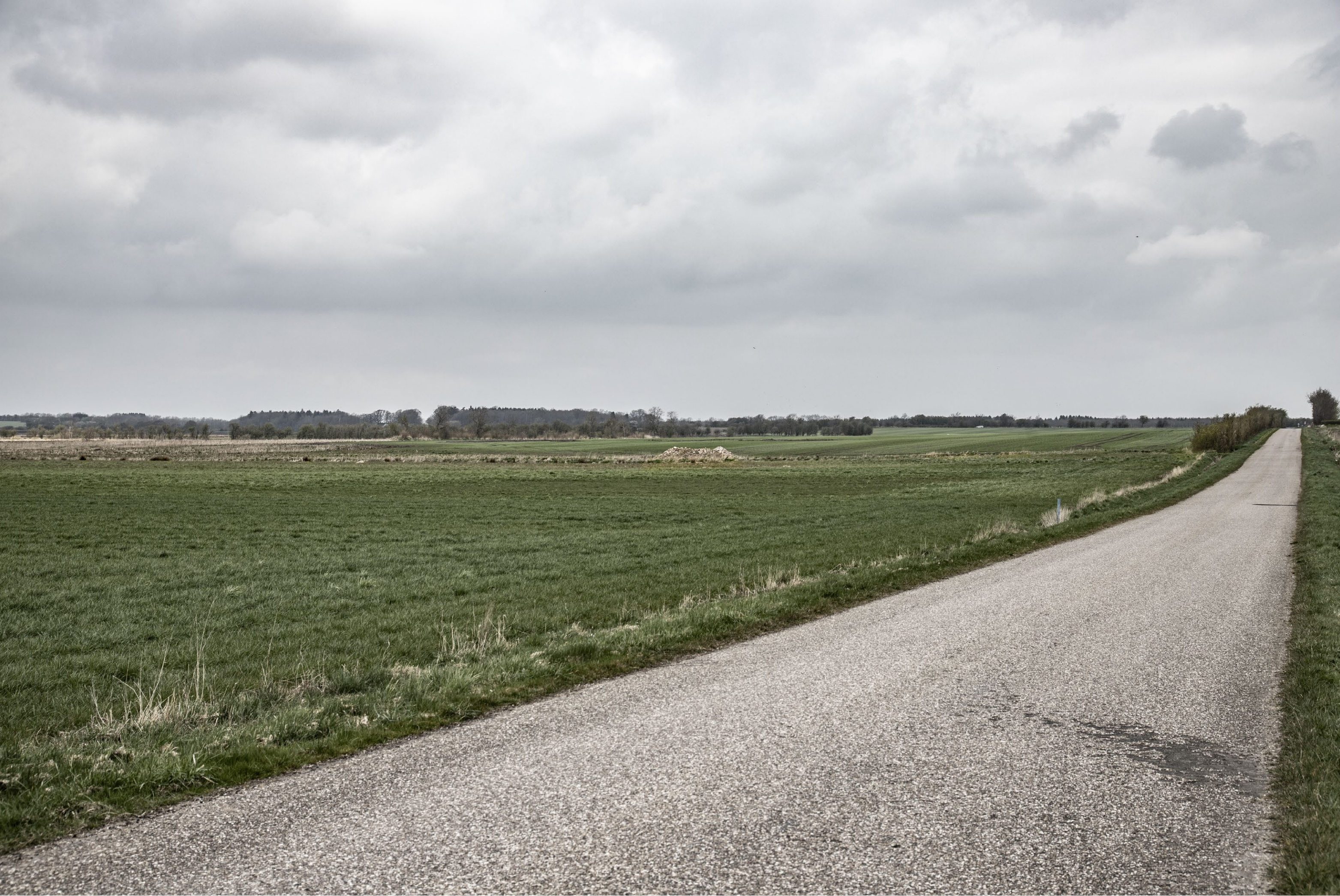
7 Eksisterende forhold, 50 mm
