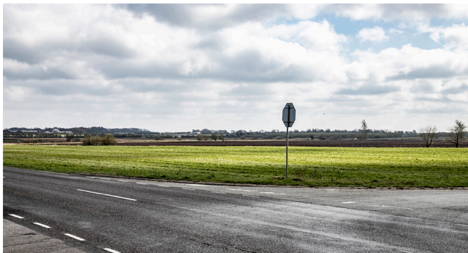
Foto af eksisterende forhold set fra krydset ved Gelsåvej/Diagonalvej mod sydøst.
