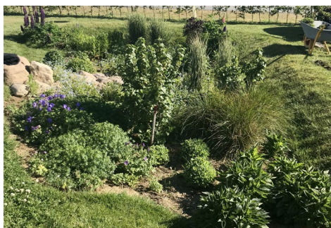
Fig. 12. Eksempel på fordybning til regnvandshåndtering
