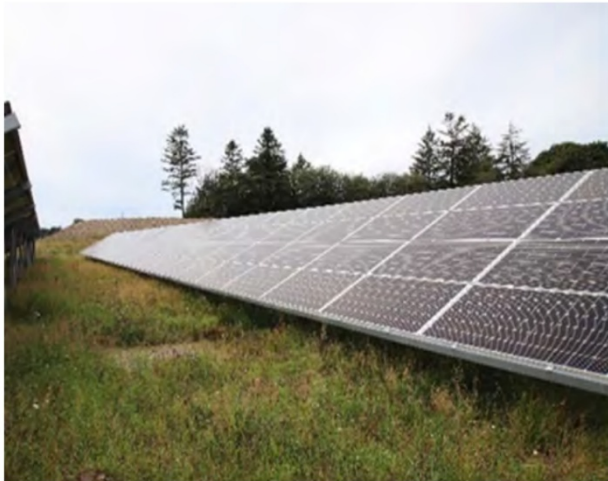
Billede 1-1 Eksempel på solcellepaneler monteret på faste stativer (til venstre) og monteret på stativer med trackersystem (til højre)
