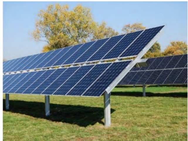
Billede 2-2 Eksempel på solcellepaneler monteret på faste stativer (til venstre) og monteret på stativer med trackersystem (til højre)
