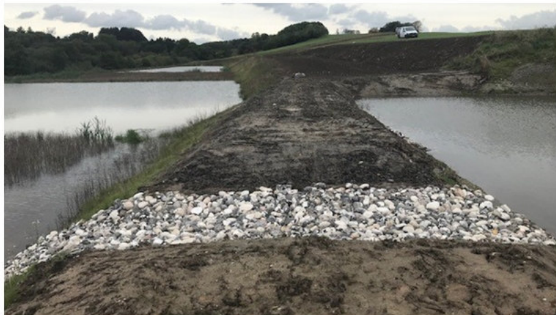
Type 1. Nødoverløb som fordybning beklædt med geotekstil eller beton og stenudlæg
