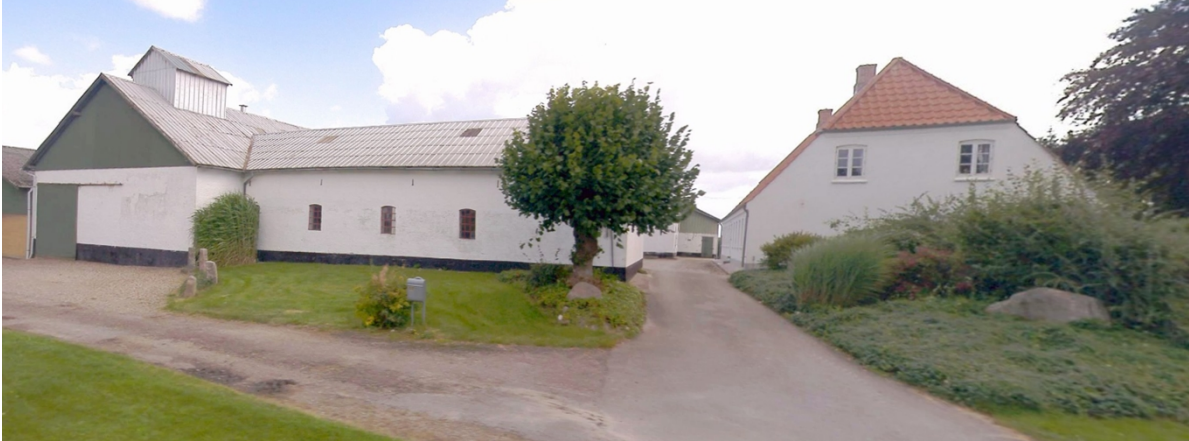
Gadefoto 2024. Bygningen der søges nedrevet ses med den grønne gavl bagest i billedet og lige til venstre for stuehuset.
