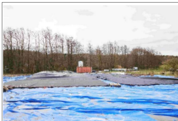
Geobags ved opstart
