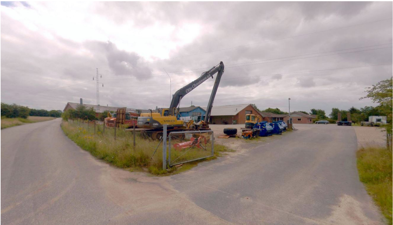
Billede 5. Adgangsvej fra Nordvangsvej mod oplagsplads, administrationsbygninger, værksted, lagerhal og maskinhal.
