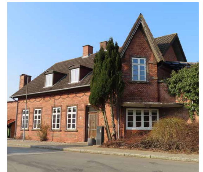
Slotsbyen udviklede sit eget butiksliv. Åvej 6 blev i 1903 opført som slagterbutik og pølsemageri. Husets skrå hjørne viser jernbanens forløb lige forbi huset. Selvom banen blev nedlagt i 1930, er dens tracé stadig direkte aflæseligt i områdets struktur.
