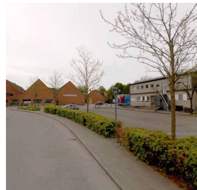
Den tidligere Brugsen-bygning fra 1982 og telefonhuset fra 1955 indrammer Torvet, som idag fremstår som tomt butikscentrum midt i byen og adskilt fra Kongevej.
