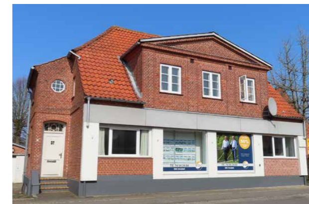
Dons Guld- og Sølvmedeforretning på Kongevej 4 i Gram blev opført i 1933. Bygningen er et fint eksempel på et tidstypisk byhus med butik i gadeplan og beboelse på 1. sal opført i blank rød tegl i Bedre Byggeskikstil. Den meget fine detaljering i murværk, døre og vinduer vidner om et dyrt byggeri til en førende butiksindehaver i byen. Omdannelsen af facaden i 1982 er ligeså tidstypisk, men mindre bevaringsværdig. Huset rummer idag en ejendomsmæglerbutik. Bygningen er vurderet bevaringsværdig med en SAVE-værdi på 3.
