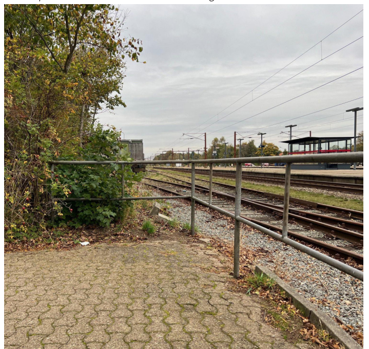
Udsigt fra tunnelforbindelse vest for jernbanetracé
