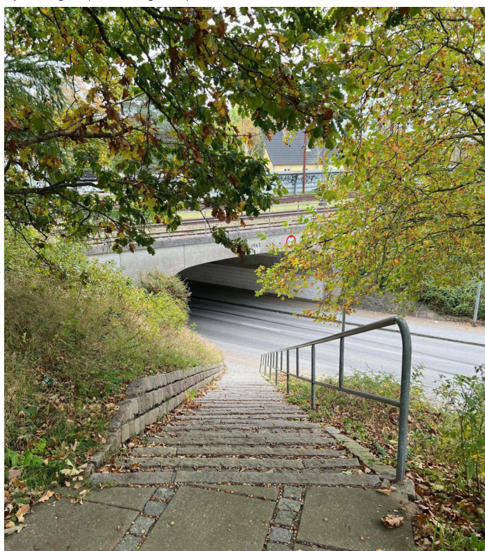
Trappe fra Rosenalle til Østergade ved viadukten
