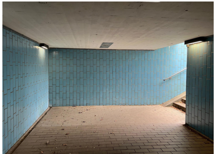
Tunnelforbindelse set mod vest til endegavl
