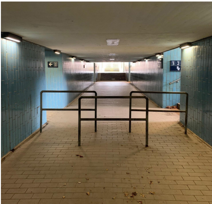
Tunnelforbindelse set mod øst
