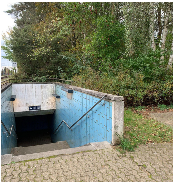
Trappe til tunnelforbindelse vest for jernbanetracé
