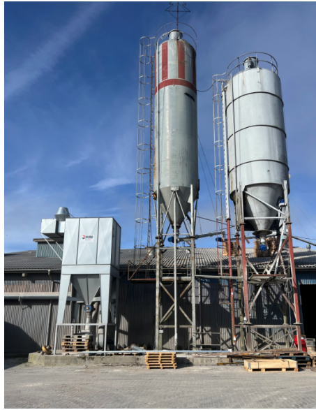
Bygning K (2 siloer) og bygning L (udsugningsanlægget til venstre)
