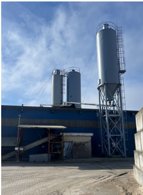
Fra ansøgningen: Silo C i forrest og siloer J i baggrunden
