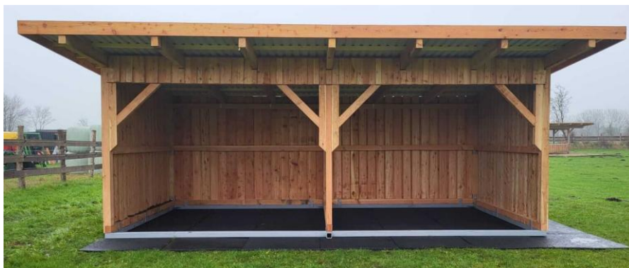
Fra ansøgningen: Modelbillede af opbevaringsbygningen (H3)
