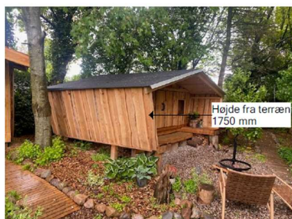
Shelter 02 set fra sydvest Tagbelægning udført i tagpap Opført i 2025
