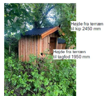
Shelter 01 set fra sydvest Tagbelægning udført i stål
