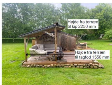
Overdækning 01 set fra vest Tagbelægning udført i bølgetagplade i bitumen Opført i 2024
