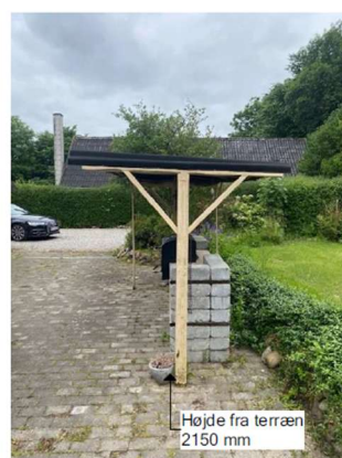
Overdækning 02 set fra øst Tagbelægning udført i bølgetagplade i bitumen Opført i 2022
