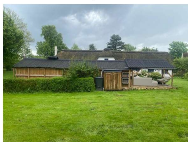
Udhus 01 set fra nord Vægge opført i træ Tagbelægning udført i bølgetagplade i bitumen Opført i 2024
